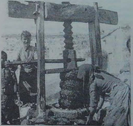
Tahta preste (Pressa) zeytin yağı çıkartılması
