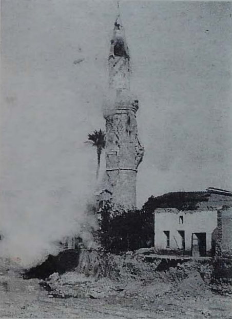
Seller sonucu heyelan nedeniyle kayan toprak ile hasar gören cami ve minare kullanılmaz duruma
