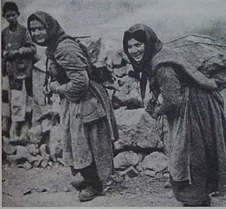
Yol inşaatında çalışan ana-kız köylüler...
