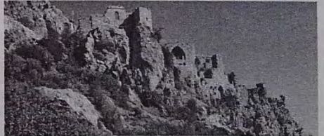
R-27 St.Hilarion Kalesinin orta kısmının genel görünüşü
