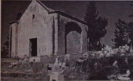
R-18 Akatu (Tatlısu) köyü Ayia Fodini Kilisesi ve tahrip edilen mezarlığı
