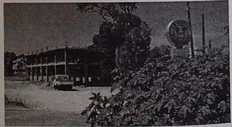
R-20 Vrysi tou Barba antik mezarlık alanının korunma alanına yapılmakta olan yeni inşaat.
