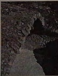
R-29 Kalenin tanıtım odasının çimento ile tamir edilen tonozu
