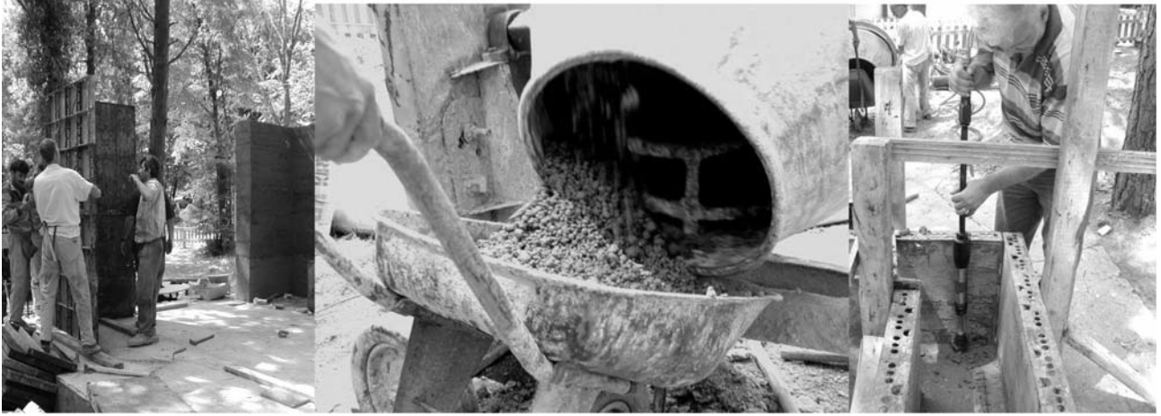
Resim.33 kalıbın kurulması, Resim. 34 harcın hazırlanması, Resim. 35 kalıba tokmaktama
