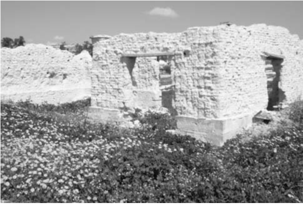
Resim.16, Akıncılar kerpiç yapı, taş subasman, Resim.17, 18 Hatıl, ara döşeme ve çatı
