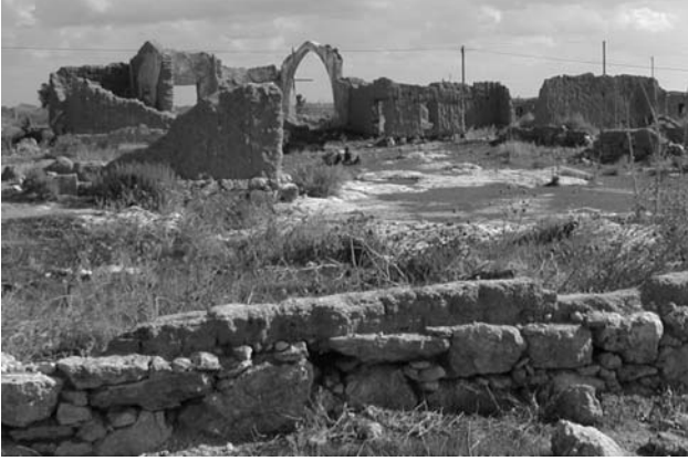
Resim.9, Sandallar kemerli yapı, yan destek mekanları;
