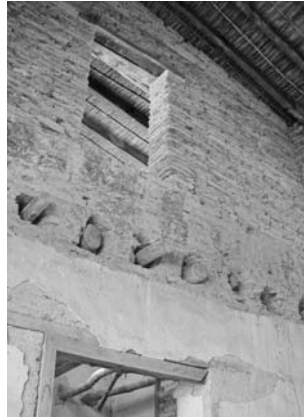
Resim.16, Akıncılar kerpiç yapı, taş subasman, Resim.17, 18 Hatıl, ara döşeme ve çatı
