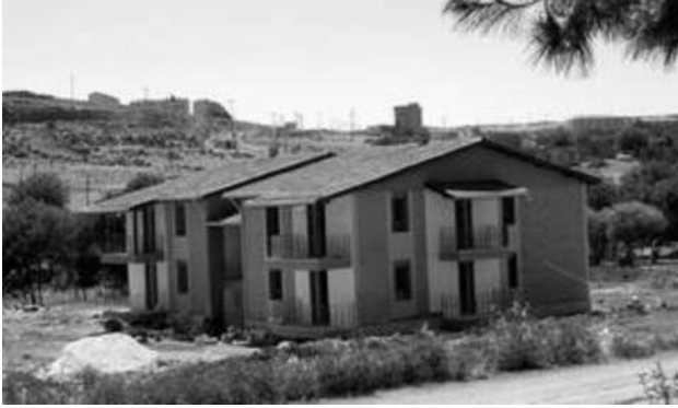
Resim.45. İTÜ GAP Alker Pilot Yapısı'nın Haziran 2000 Görünüşü
