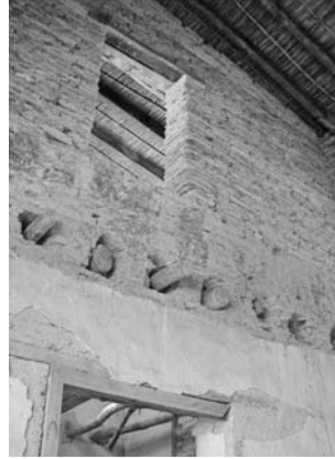
Resim.16, Akıncılar kerpiç yapı, taş subasman, Resim.17, 18 Hatlı, ara döşeme ve çatı
