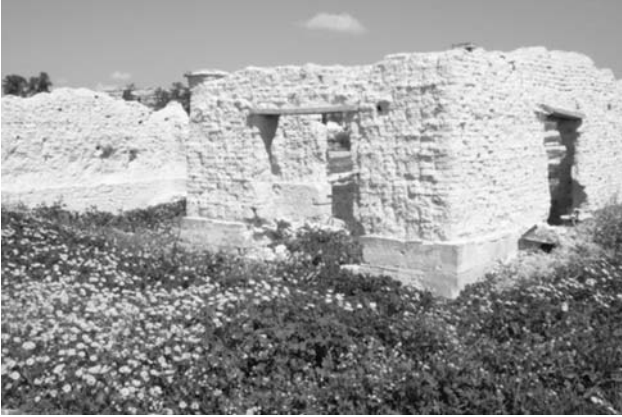
Resim.16, Akıncılar kerpiç yapı, taş subasman, Resim.17, 18 Hatlı, ara döşeme ve çatı
