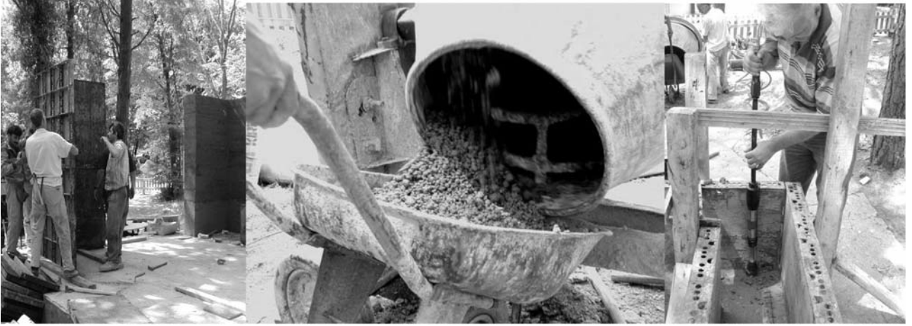
Resim.33 kalıbın kurulması, Resim. 34 harcın hazırlanması, Resim. 35 kalıba tokmaktama
