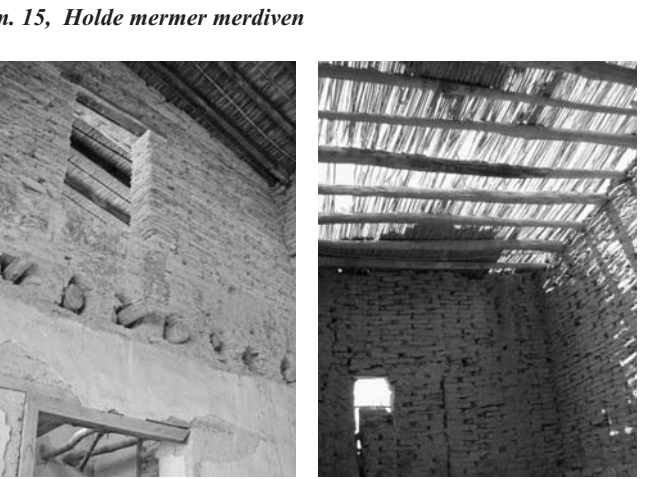
Resim.16, Akıncılar kerpiç yapı, taş subasman, Resim.17, 18 Hatlı, ara döşeme ve çatı
