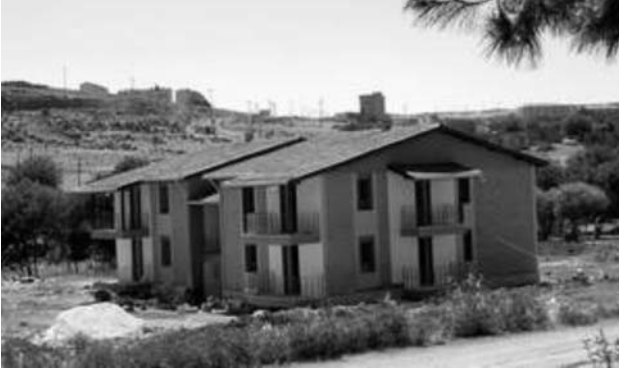
Resim.45. İTÜ GAP Alker Pilot Yapısı'nın Haziran 2000 Görünüşü
